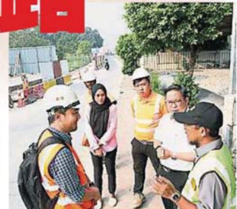
轻快铁施工人员 (左一至三) 正向沙哈里 (右一) 解释封路的原因和进度, 右二为梁德志。
